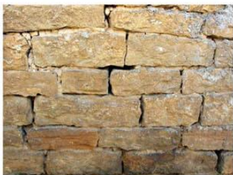
Illustrations 27 et 28. Détail appareil du mur et couleur des pierres
