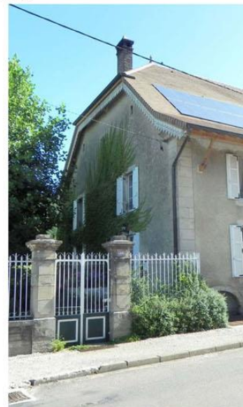
Illustration 31. Éléments de finition sous toiture
