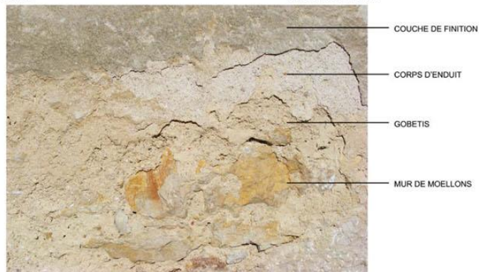
Illustration 16. Détail mur enduit
