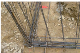
Nœud de chaînage - Continuité mécanique
