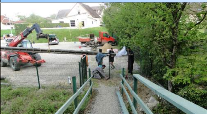
Nouvelle passerelle en direction du lavoir de la Jambonne construite avec de gros moyens
