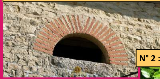
N° 1 : Lucarne maison Arnal rue d'Amont
