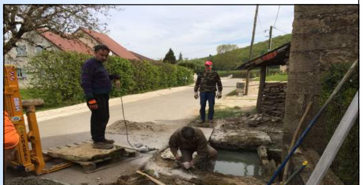
Réfection des bords avec un empiérement lourd et l'expertise de la taille de Serge ARNAL
