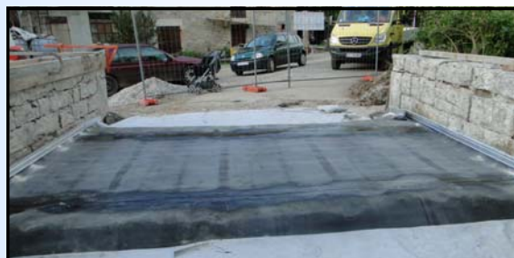
Le tablier et les arches on été renforcés.
