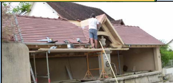
... la pose des tuiles...
