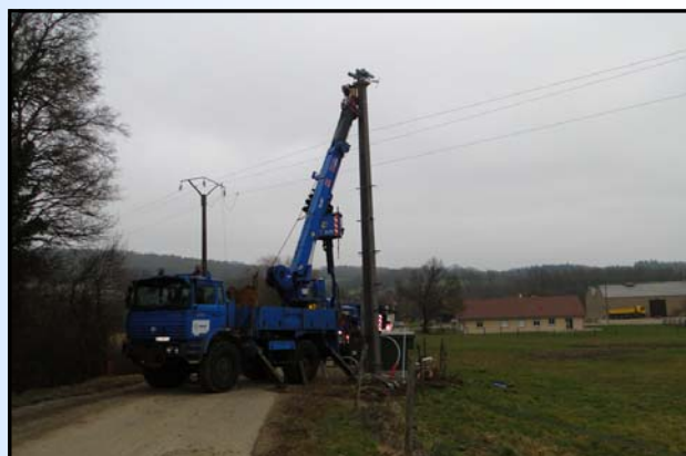
Pose d'un transformateur et d'un poteau plus haut par les entreprises spécialisées.
