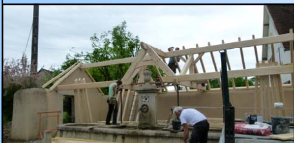
Après la démolition, pose de la charpente...
