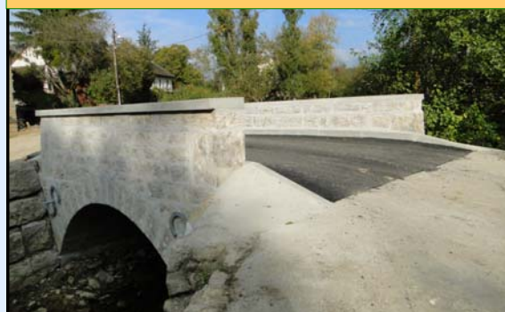
Le tablier et les arches on été renforcés.
